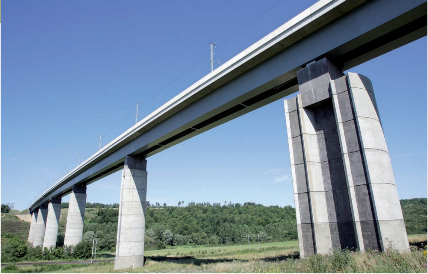
Viaduc de Jaulny LGV Est (54).
